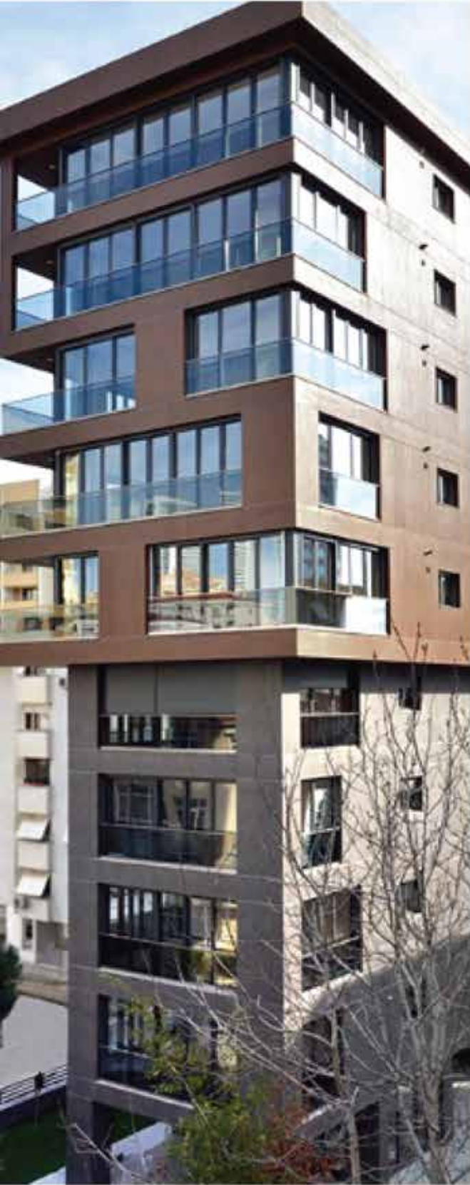
PROTEK İNŞAAT / PINAR APT. - FENERYOLU
